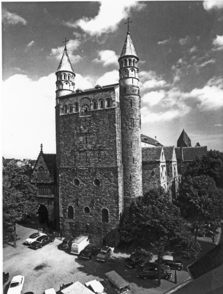
19 Maastricht, Liebfrauenkirche, Westseite
